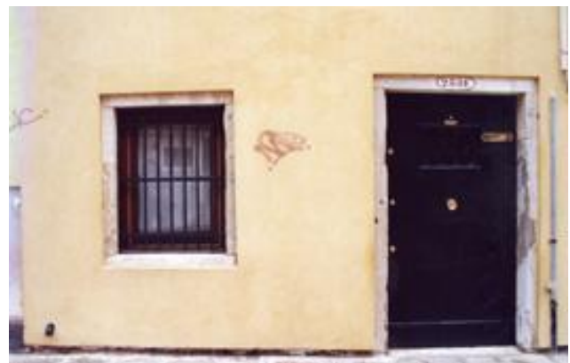
Βενετσιάνικος τοίχος | Venetian wall
