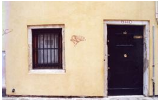
Βενετσιάνικος τοίχος | Venetian wall
